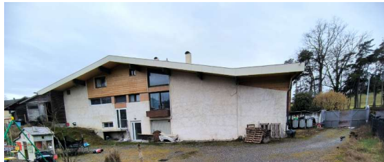
Façade sur cour
