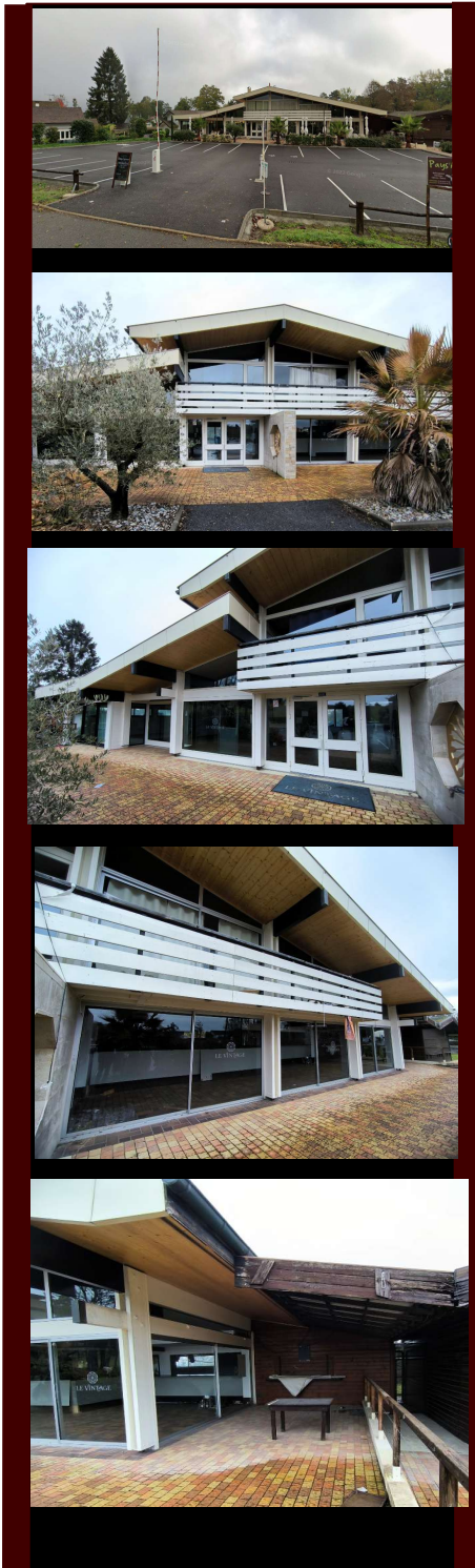
FACADE SUR ROUTE
